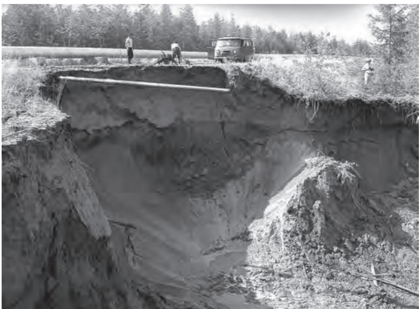
Рис. 2. Надземный трубопровод в Якутии, проложенный по территории с реликтовыми мощными повторно-жильными льдами. Фото А.Н. Федорова, Институт мерзлотоведения (Станиловская, Мерзляков, 2013).
