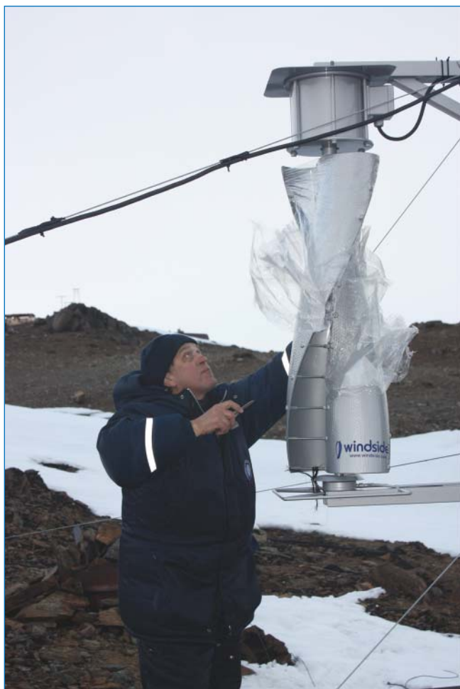
Установка ветрогенератора для автоматической метеостанции Русская
