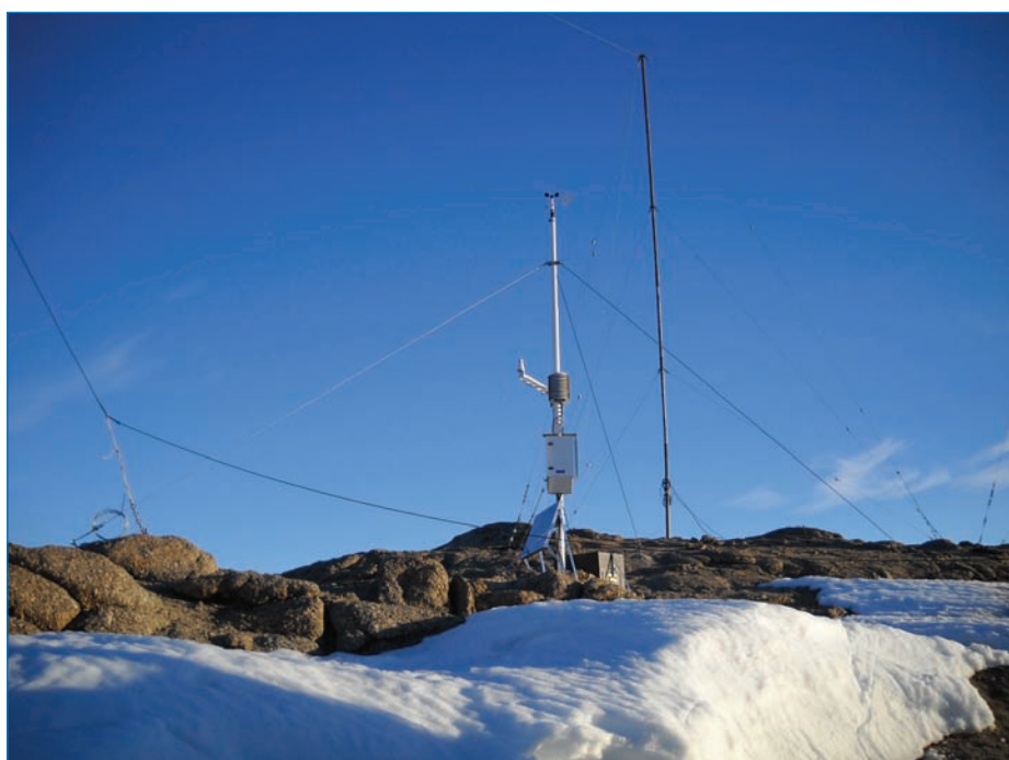
AMS на станции Дружная-4
