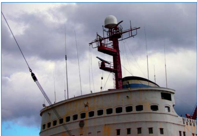
Станция VSAT, смонтированная на НЭС «Михаил Сомов».
