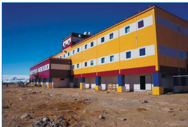
Вид служебно-жилого здания с севера.
