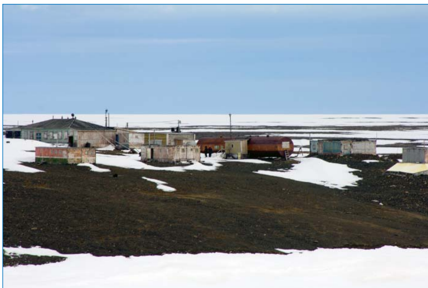
Комплекс сооружений станции «Мыс Баранова».
