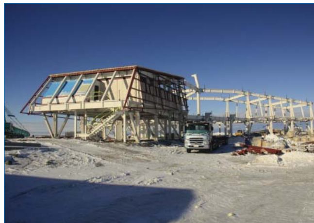
Монтаж здания станции. 3 марта 2013 г. Фото О.Фоломеева.
