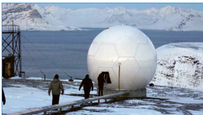
Осмотр спутниковых станций.
