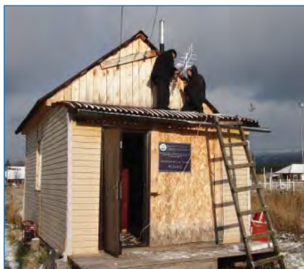
Установка антенны радиотерминала на станции Вельмо Среднесибирского УГМС.
