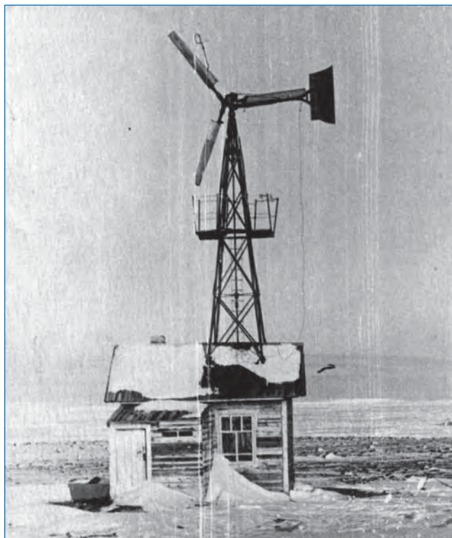
Ветрогенератор Д-5 на о. Рудольфа. Фото Е.Д. Ананьева, апрель 1954 г. (РГАЭ, ф. 9570, оп. 2, д. 3317, л.122).
