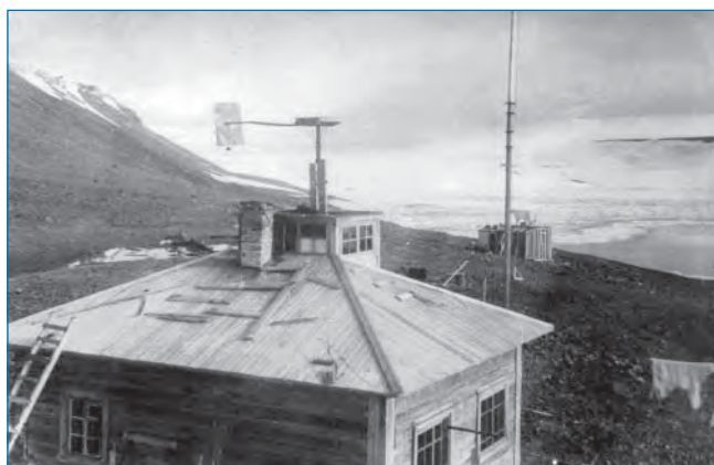
Самодельный ветродвигатель на крыше здания мехчасти летом 1951 г. Пропеллер снят. Автор неизв. (РГАЭ, ф. 9570, оп. 2, д. 3126, л. 9а).
