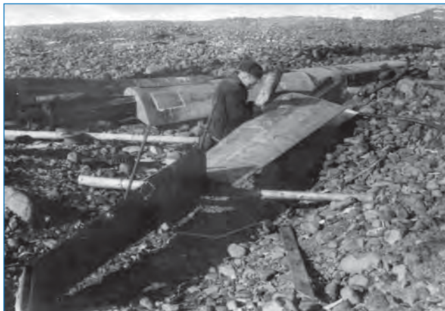
Пайка крыльев ветродвигателя Д-12 летом 1951 г. Автор неизв. (РГАЭ, ф. 9570, оп. 2, д. 3126, л. 9).
