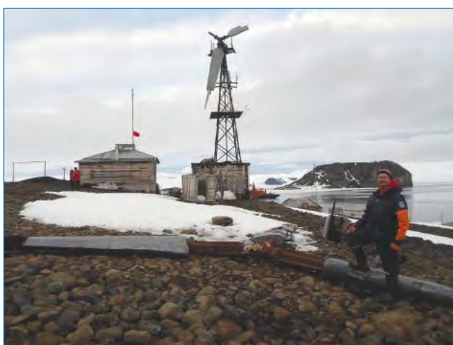
Современный вид в/д Д-12 в б. Тихая. На переднем плане тройник с лопастями от аналогичного ветродвигателя 1939 г. Июль 2014 г. Фото автора
