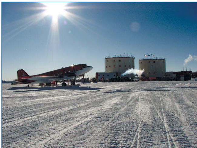
Главное здание станции Конкордия.
