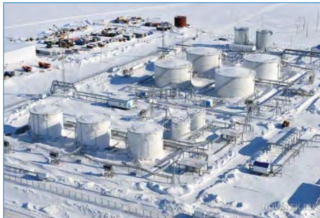
Строительная площадка завода «Ямал СПГ»
