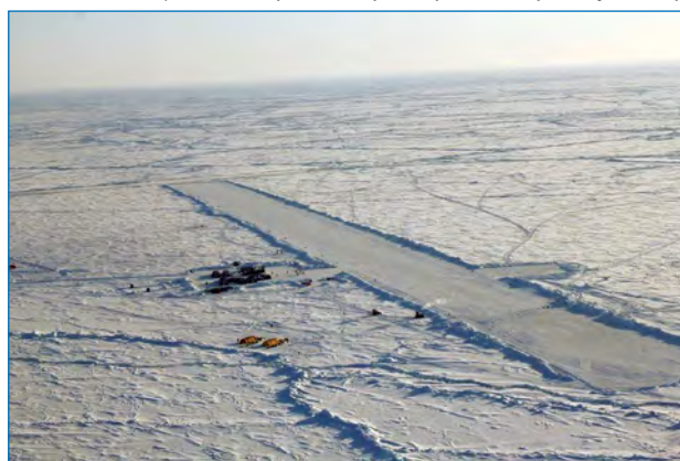
Ледовый лагерь «Барнео» и ледовый аэродром (апрель 2018 года). На снимке видна трещина, которая прошла поперек взлетно-посадочной полосы, сократив ее размеры почти на треть
