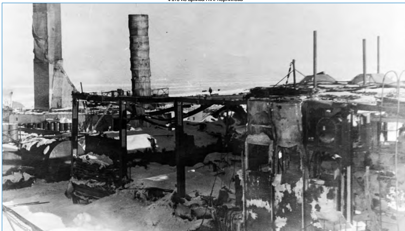
Останки дизель-электростанции на станции Восток после пожара. Фото из архива Н.А. Корнилова
