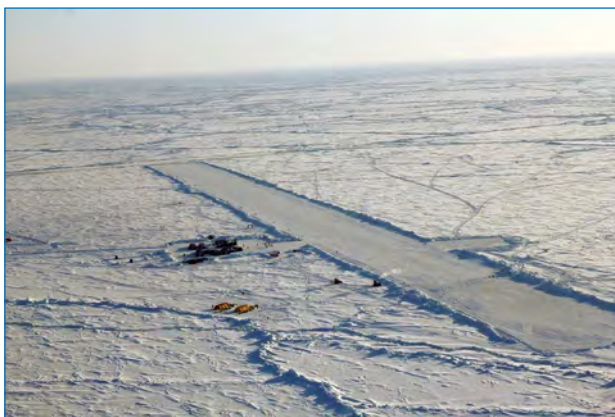
Ледовый лагерь «Барнео» и ледовый аэродром (апрель 2018 года). На снимке видна трещина, которая прошла поперек взлетно-посадочной полосы, сократив ее размеры почти на треть
