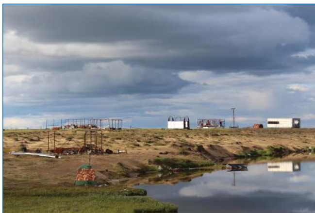
Разрушенные строения законсервированного в 1995 году научно-исследовательского стационара Парисенто. С 2016 года в ЯНАО приступили к его восстановлению
