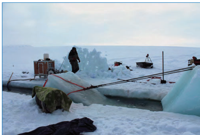
Установка на дно второго ледяного блока
