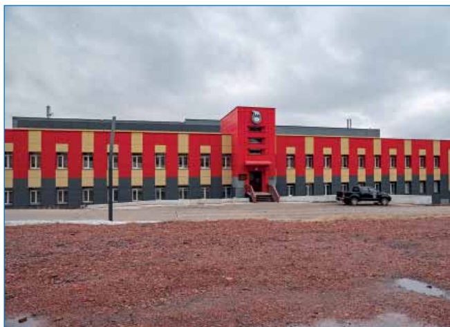
Здание треста «Арктикуголь» в Баренцбурге. Фото М.А. Карандеева
