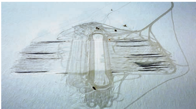
Уплотнение площадки под строительство НЗК Восток. Фото К.А. Овчинникова
