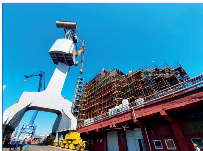
Корпус ЛСП «Северный полюс»
