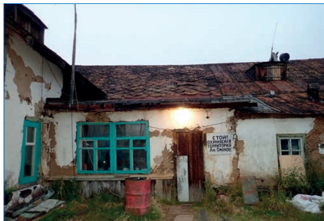
Здание гаража и крыши из американских бочек в пос. Омолон. Фото П.А. Филина
