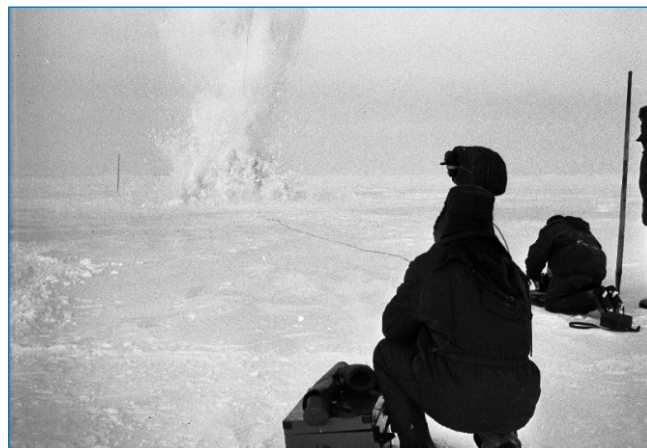
Проведение взрывных работ в экспедиции А-162Д. Архив В.П. Трипольникова
