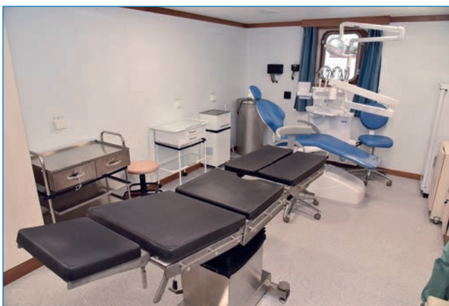
Помещение медицинского блока
