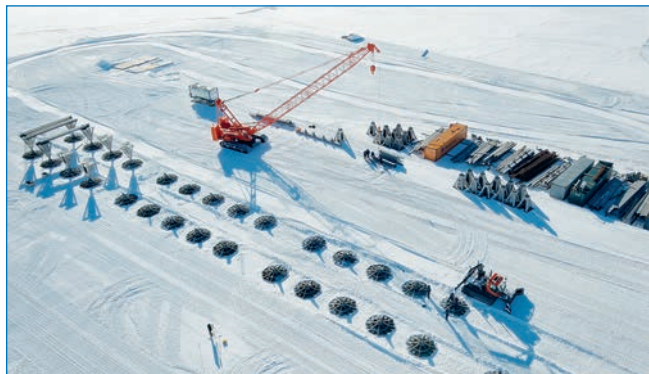
Установка опор фундамента НЗК на станции Восток. Фото А.В. Миракина
