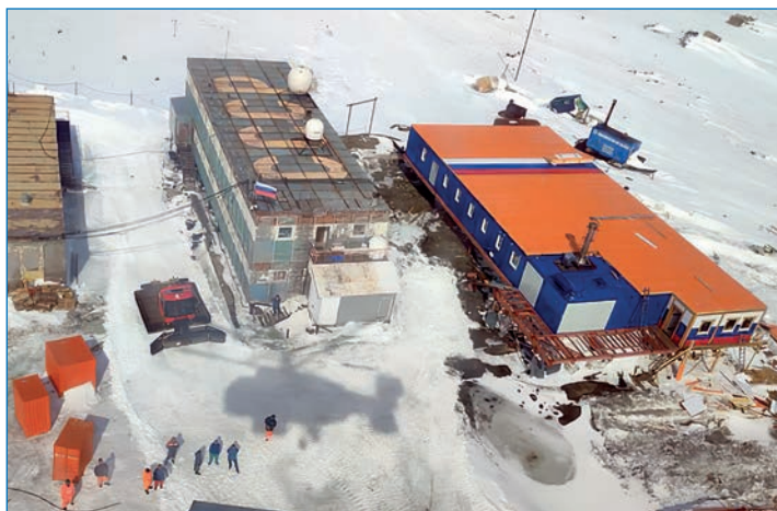
Новое здание сезонного модульного комплекса на 26.01.2023 (на фото справа)
