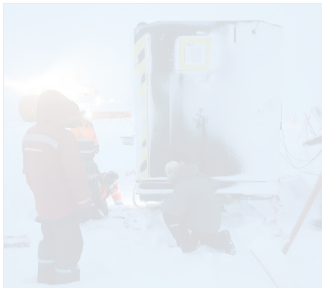
Работы по укреплению геофизического павильона в ледовом лагере. 22 октября 2023 года
