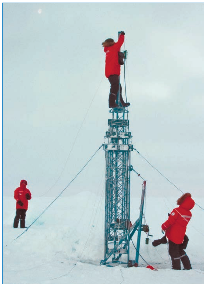
Установка телескопической мачты для геофизических исследований. Октябрь 2022 года. Фото И.А. Свистунова
