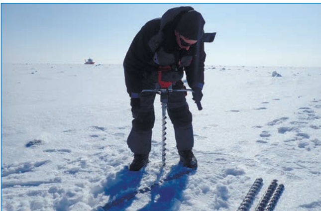
Ледяная каша и работы на смерзшемся канале. Фото А.В. Савицкой
