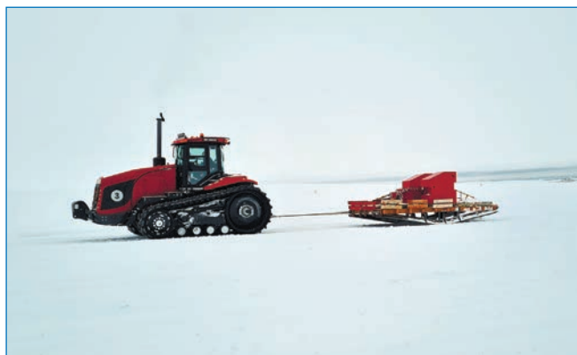
Уплотнение снежного слоя с помощью уплотняющей платформы
