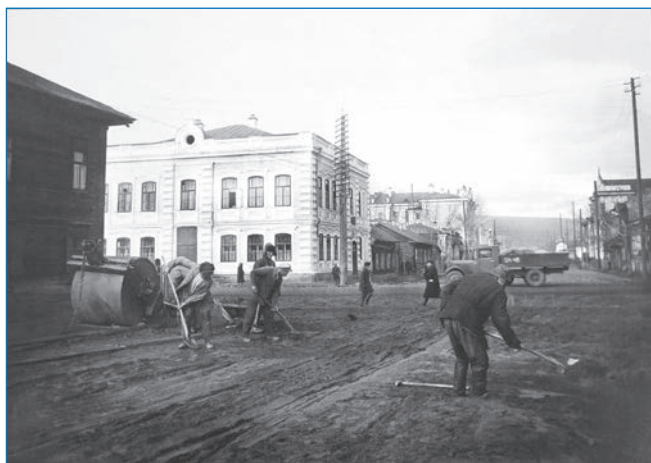
Укладка асфальта на перекрестке улиц Перенсона и Карла Маркса. 1938 год. https://pastvu.com/p/706652
