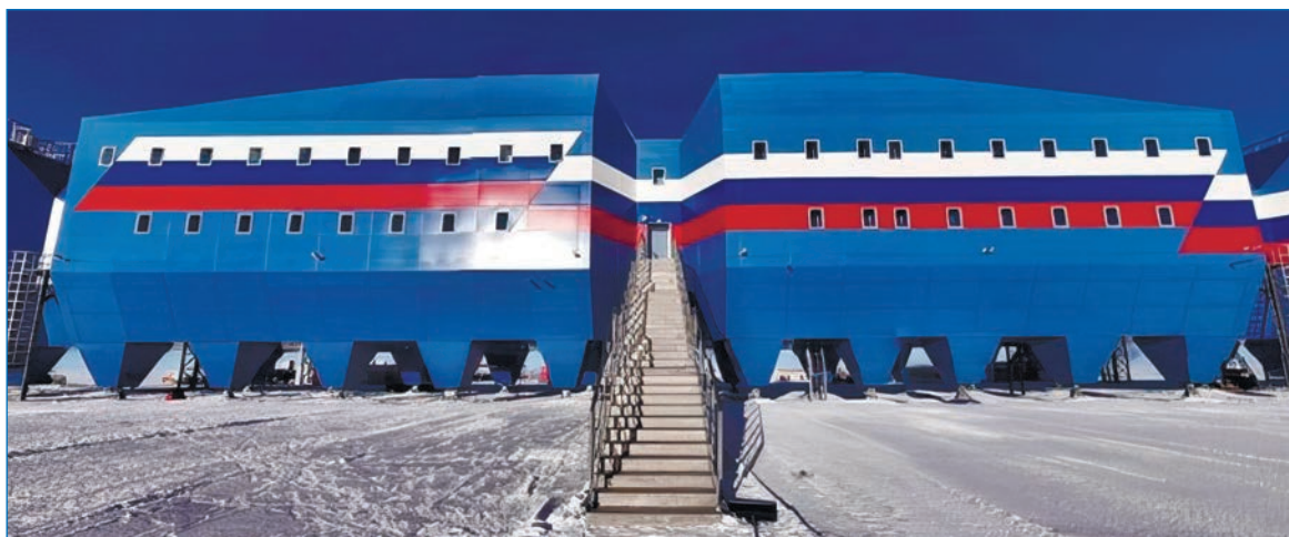
Новый зимовочный комплекс на станции Восток
