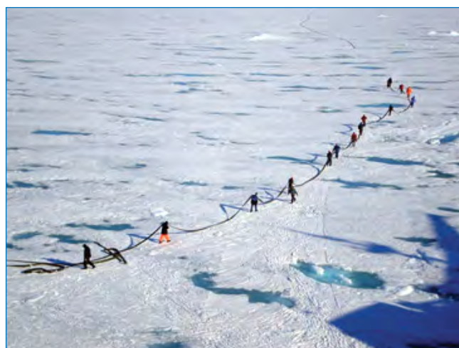
Рис. 2. Прокладка топливной шланговой линии в бухте Тала.
