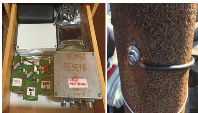
Рисунок 17.8 – Демонтаж блока предусилителей ОНЧ приемника (слева) и точка заземления вертикальной электрической антенны (справа)
