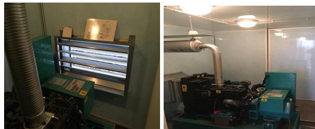
Рисунок 17.19 – Система резервного энергоснабжения
