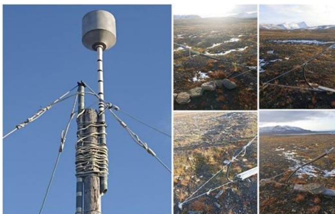
Рисунок 17.9 – Состояние креплений магнитных рамочных антенн
