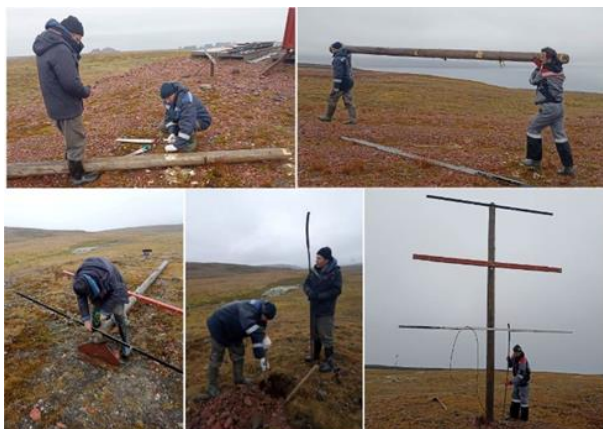
Рисунок 17.12 – Этапы создания и установки антенны риометрического приемника
