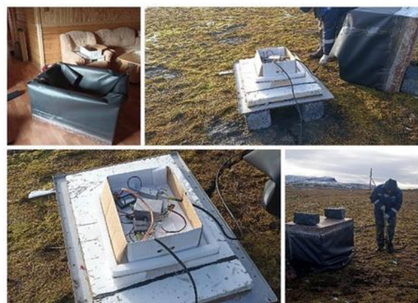
Рисунок 17.14 – Процесс установки бокса с приемной аппаратурой
