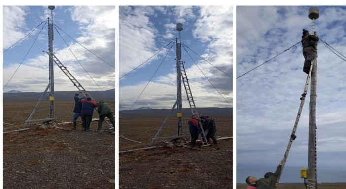
Рисунок 17.10 – Работы по устранению провисания антенных полотен магнитных рамочных антенн ОНЧ приемника
