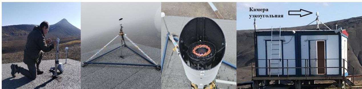
Рисунок 17.8 – Общий вид КУ, установленной на крыше технического здания
