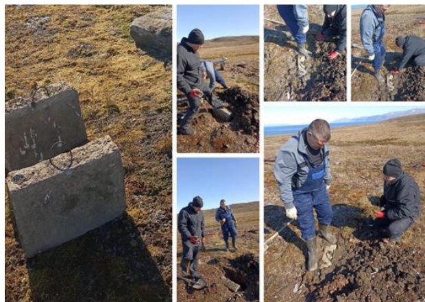
Рисунок 17.19 – Этапы вкапывания блоков для крепления оттяжек антенны
