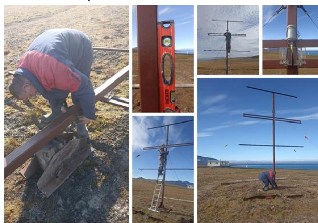
Рисунок 17.20 – Установка и подключение антенны
