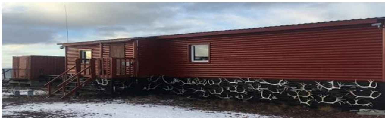
Рисунок 18.17 – Обсерватория ПГИ «Баренцбург» (здание рабочего павильона, санитарно-техническая платформа жизнедеятельности)
